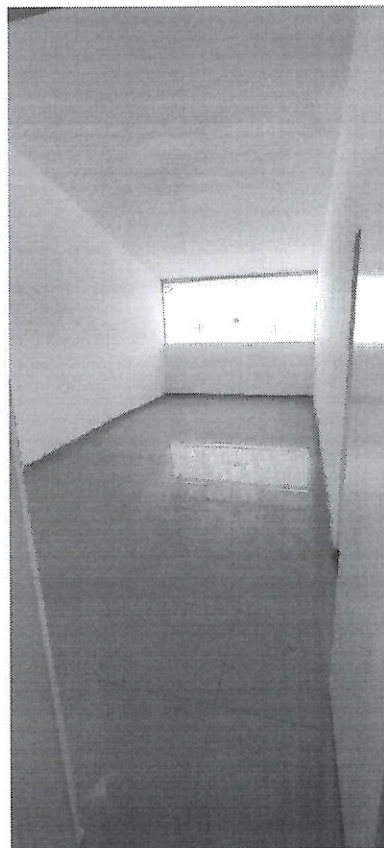
Imagem 05: Sala "Tipo" Pavimento 01
