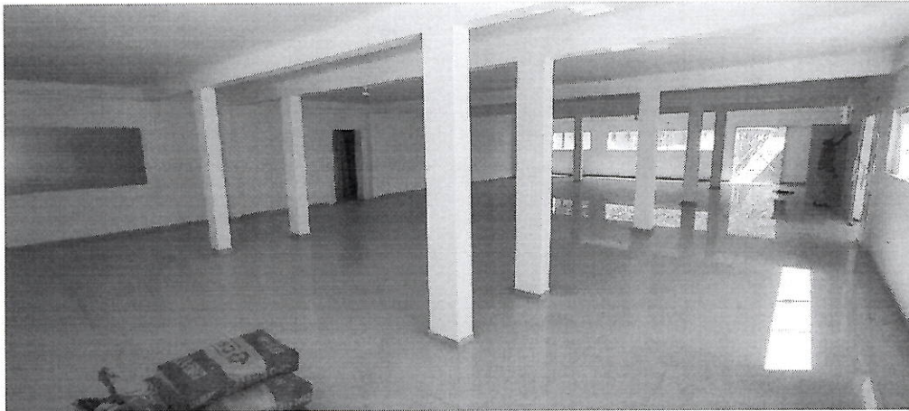
Imagem 04: Vista Parcial Pavimento 01
