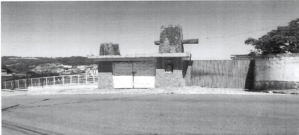
Imagem 01: Fachada do Imóvel
