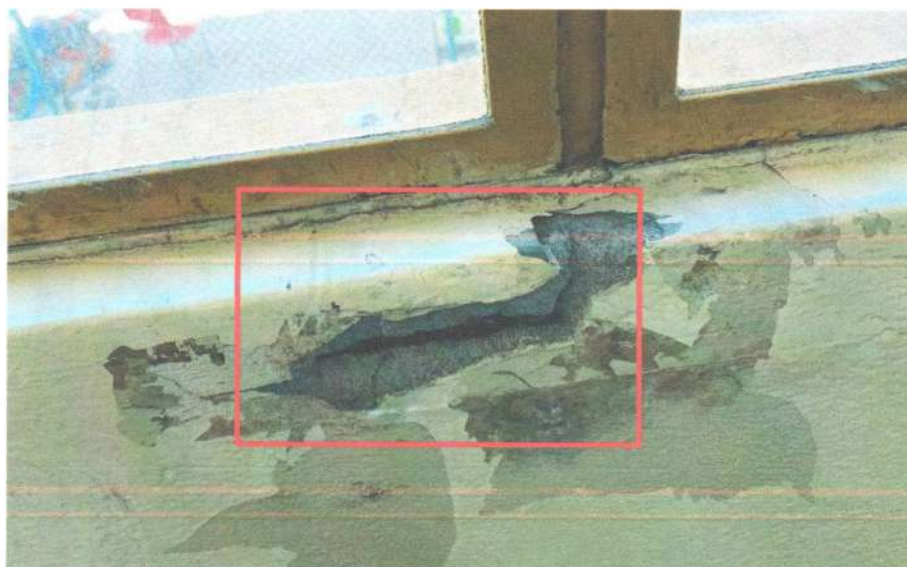
Peitoril/contraverga com corrosão na armadura
