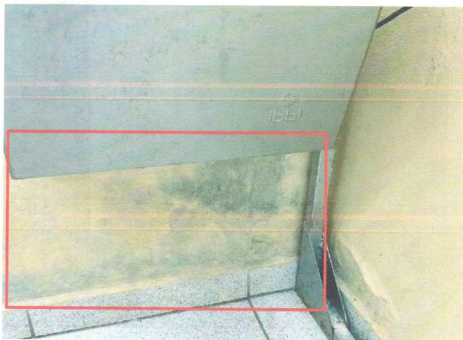
Foto 12 – Umidade por capilaridade ascendente (Prioridade II, Classificação 3)
