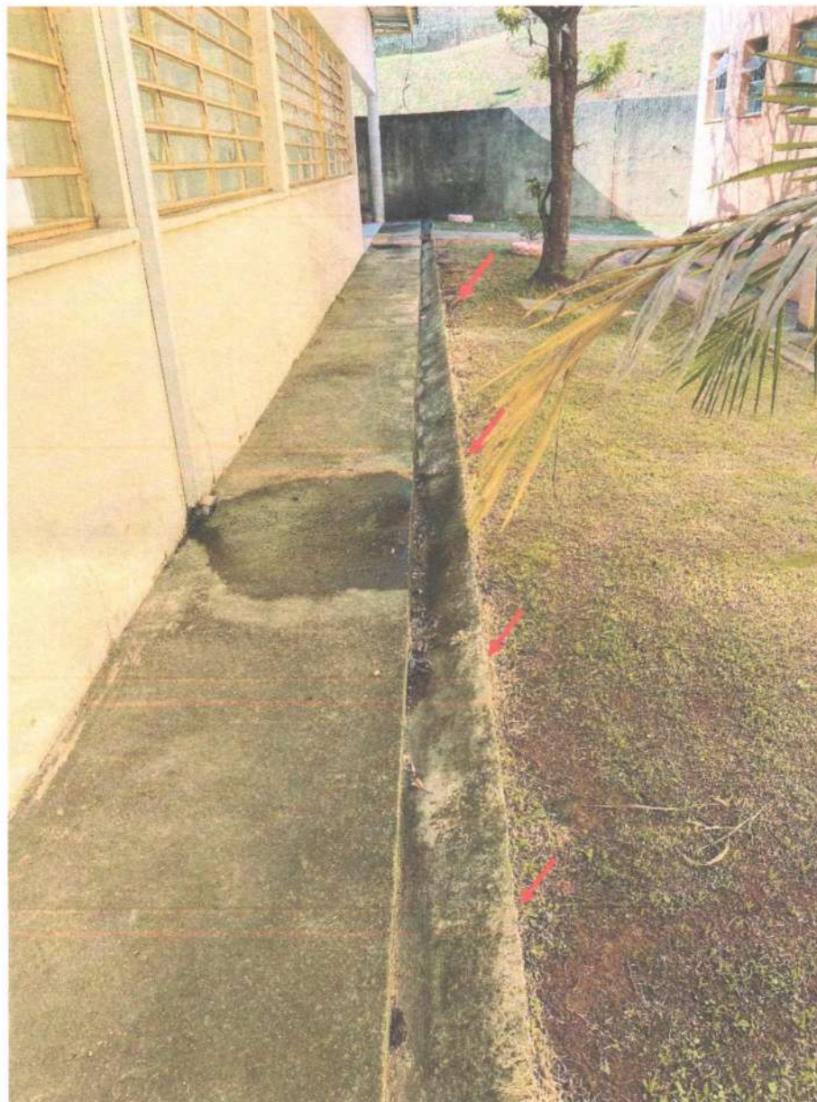
Foto 16 – Deficiência no sistema de drenagem pluvial (Prioridade I, Classificação 5)
