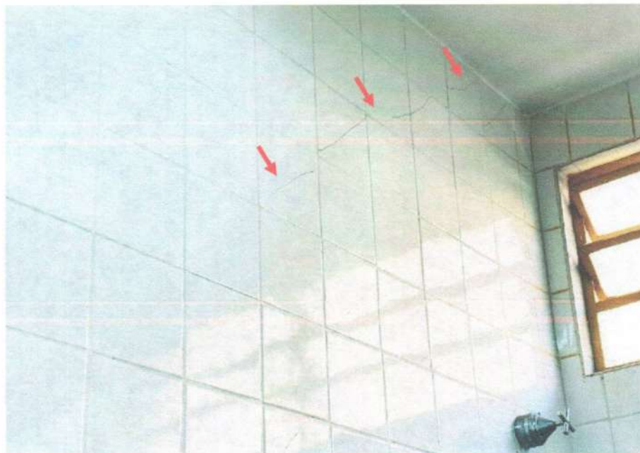
Foto 13 – Trincas e/ou fissuras (Prioridade I, Classificação 5)
