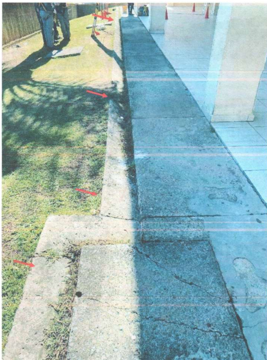
Foto 55 – Deficiência no sistema de drenagem pluvial (Prioridade I, Classificação 5)
