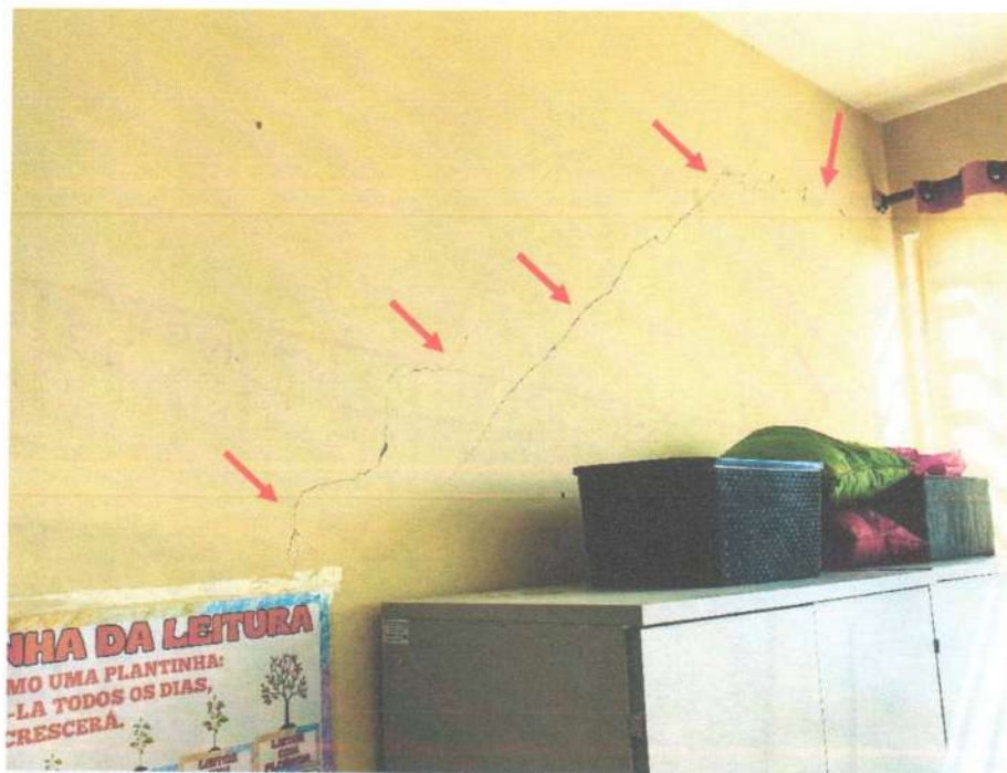
Foto 31 – Trincas e/ou fissuras (Prioridade I, Classificação 5)
