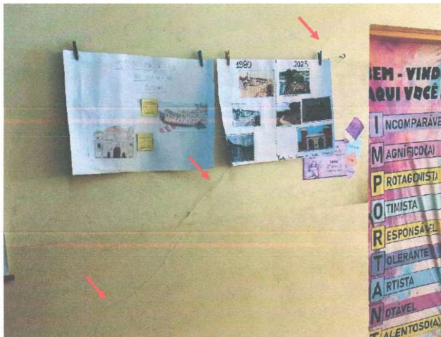
Foto 6 – Trincas e/ou fissuras (Prioridade I, Classificação 5)
