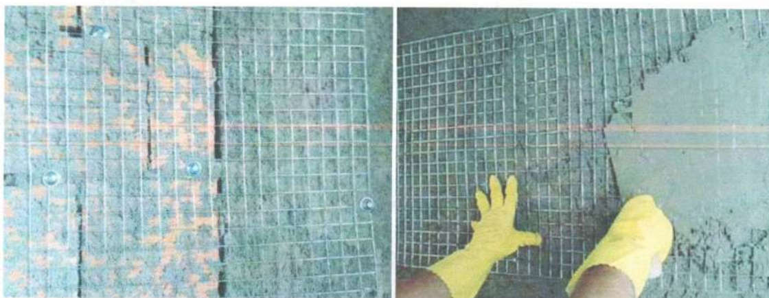
Execução da fixação da tela e preenchimento com argamassa
