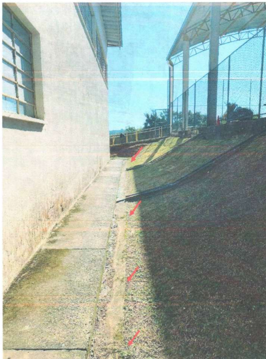
Foto 44 – Deficiência no sistema de drenagem pluvial (Prioridade I, Classificação 5)
