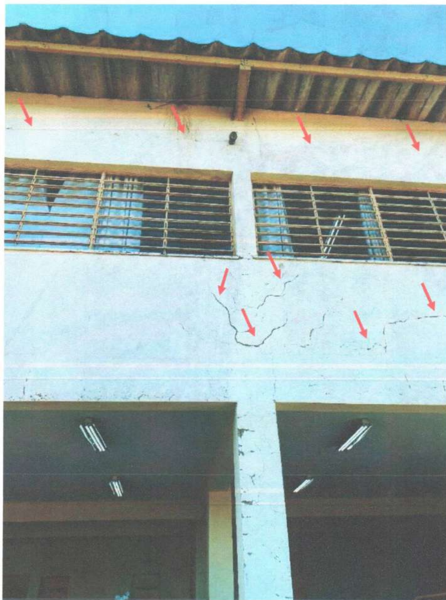
Foto 54 – Trincas e/ou fissuras (Prioridade I, Classificação 5)
