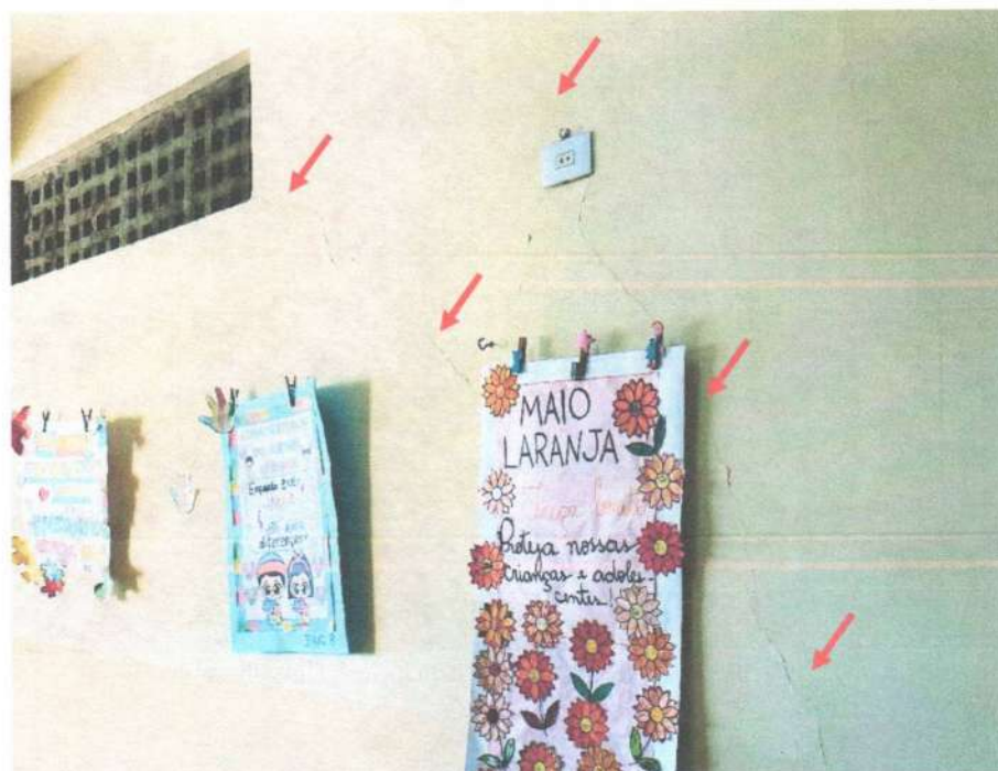
Foto 7 – Trincas e/ou fissuras (Prioridade I, Classificação 5)
