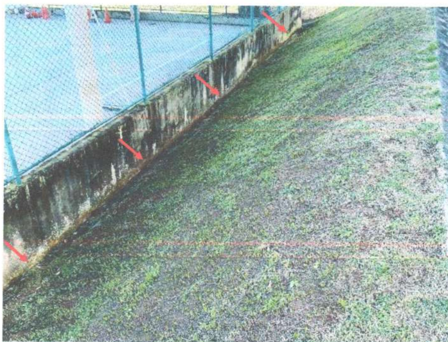
Foto 23 – Deficiência no sistema de drenagem pluvial (Prioridade I, Classificação 5)
