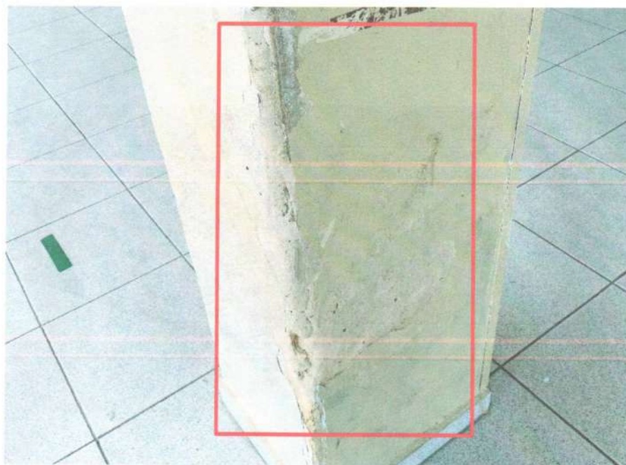
Foto 40 – Desagregação do reboco (Prioridade II, Classificação 3)
