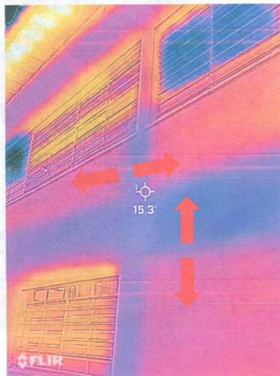
Exemplo de movimentações térmicas e dimensionais
