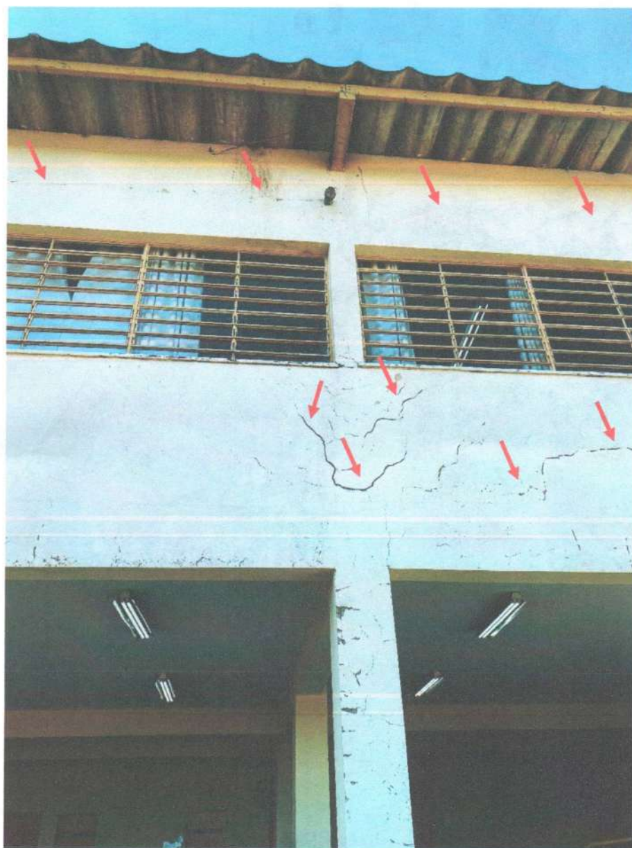
Foto 54 – Trincas e/ou fissuras (Prioridade I, Classificação 5)
