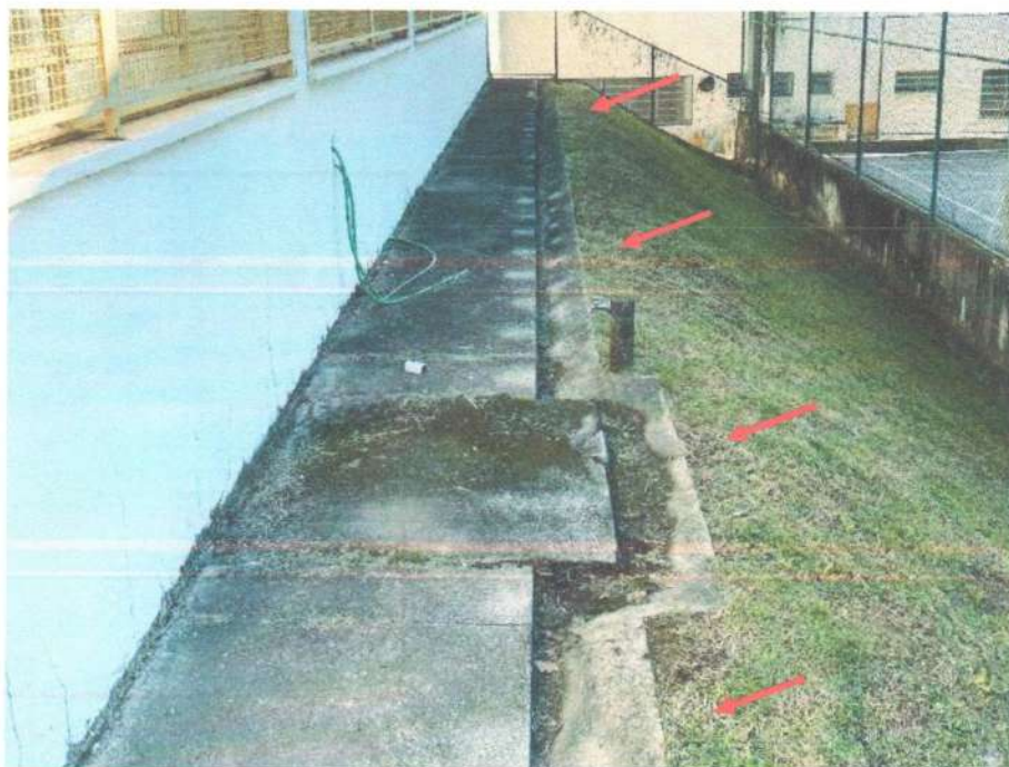
Foto 22 – Deficiência no sistema de drenagem pluvial (Prioridade I, Classificação 5)
