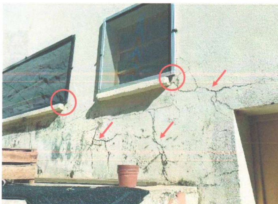
Foto 46 – Trincas e/ou fissuras e deficiência nas pingadeiras (Prioridade II, Classificação 3)
