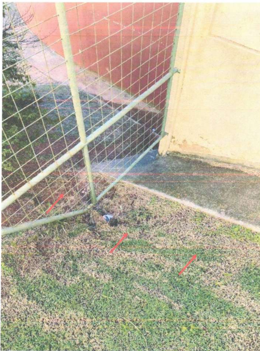
Foto 15 – Deficiência no sistema de drenagem pluvial (Prioridade I, Classificação 5)
