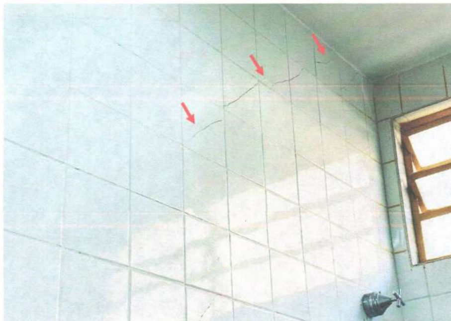
Foto 13 – Trincas e/ou fissuras (Prioridade I, Classificação 5)
