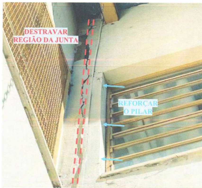
Pilar travado com fissurações
