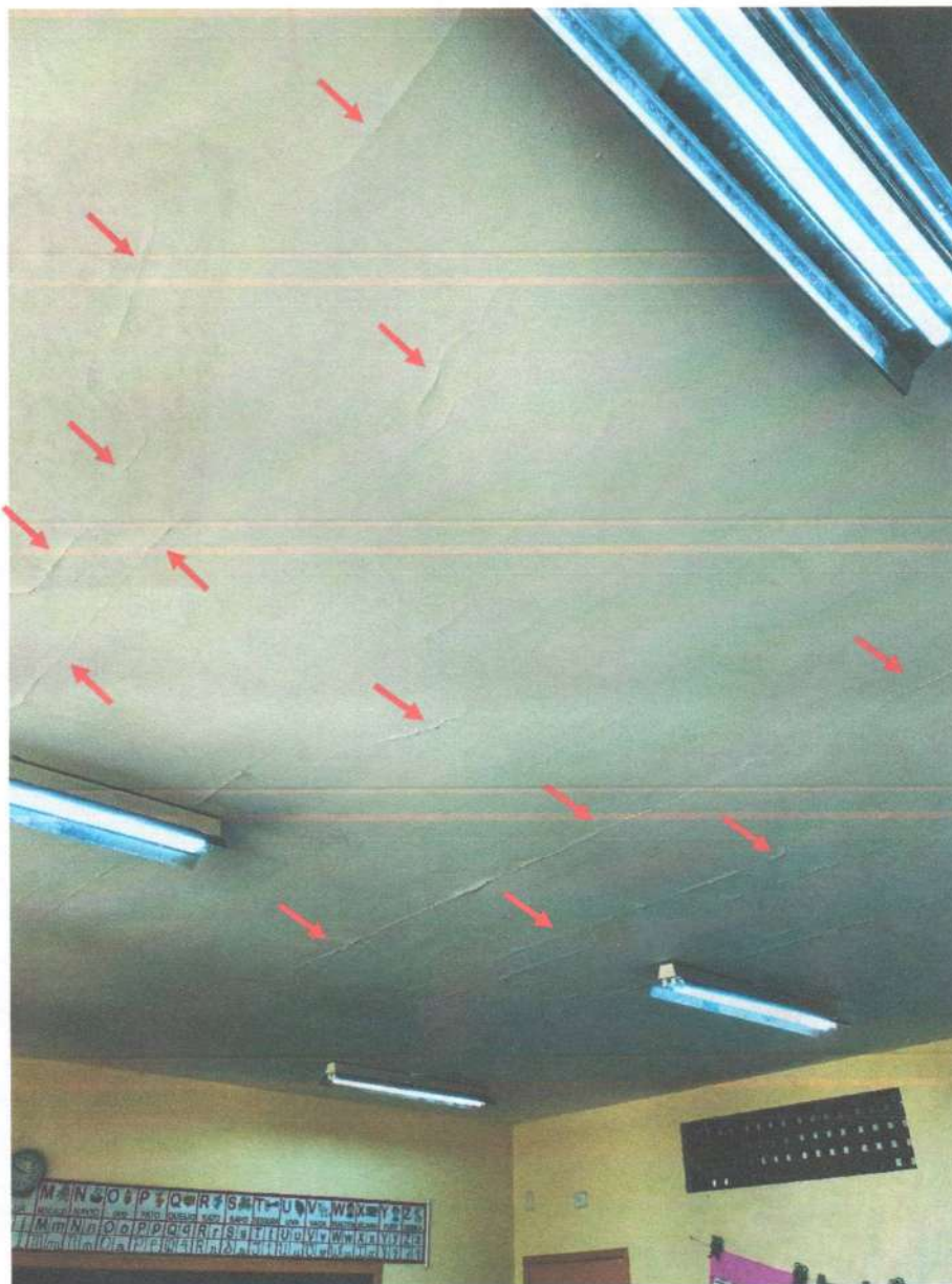
Foto 10 – Trincas e/ou fissuras (Prioridade II, Classificação 4)
