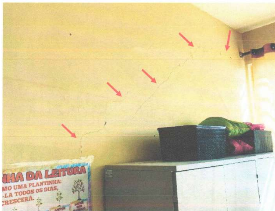
Foto 31 – Trincas e/ou fissuras (Prioridade I, Classificação 5)
