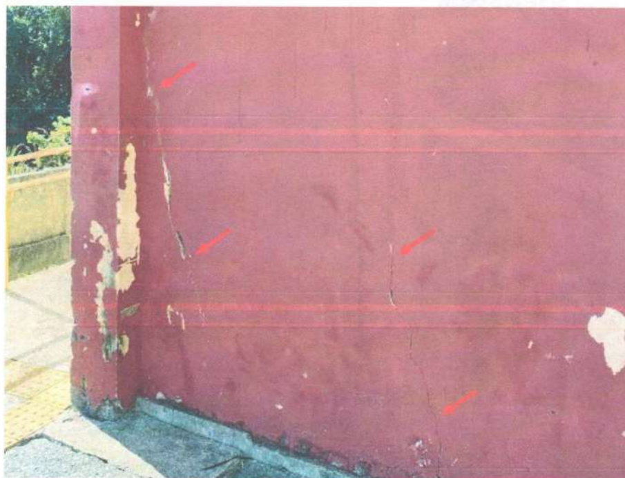
Foto 50 – Trincas e/ou fissuras (Prioridade I, Classificação 5)
