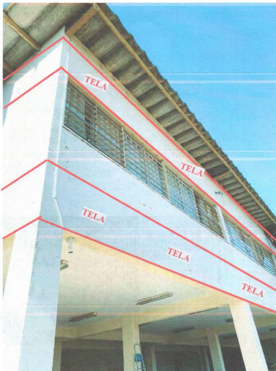
Exemplo da aplicação da tela na estrutura e alvenaria
