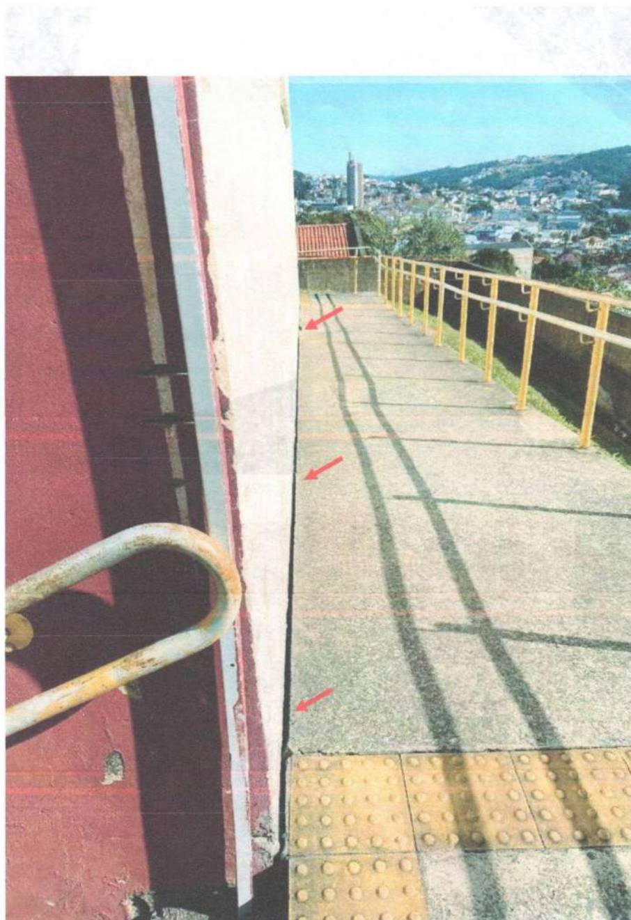
Foto 51 – Recalque de piso (Prioridade I, Classificação 5)
