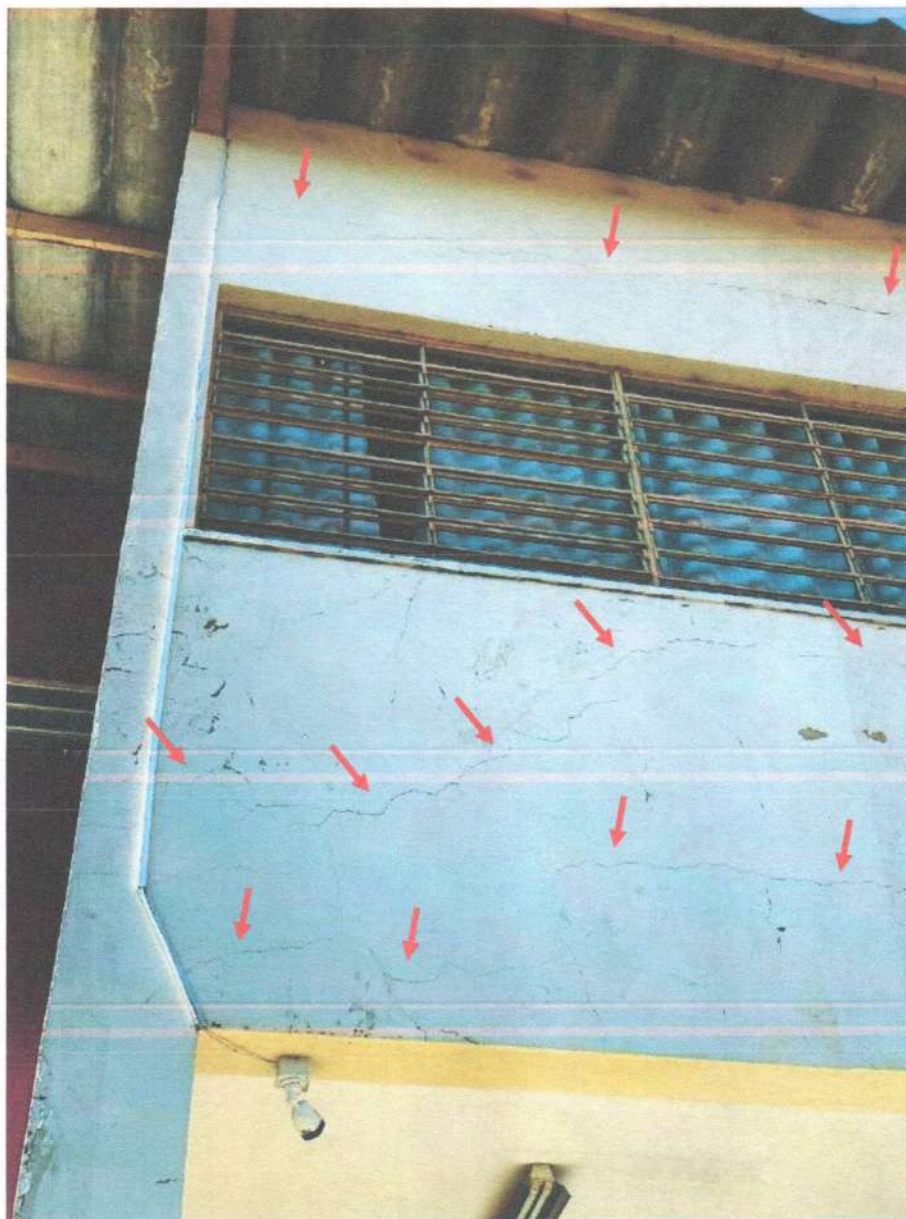
Foto 53 – Trincas e/ou fissuras (Prioridade I, Classificação 5)
