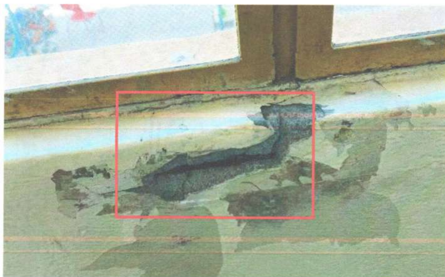
Peitoril/contraverga com corrosão na armadura
