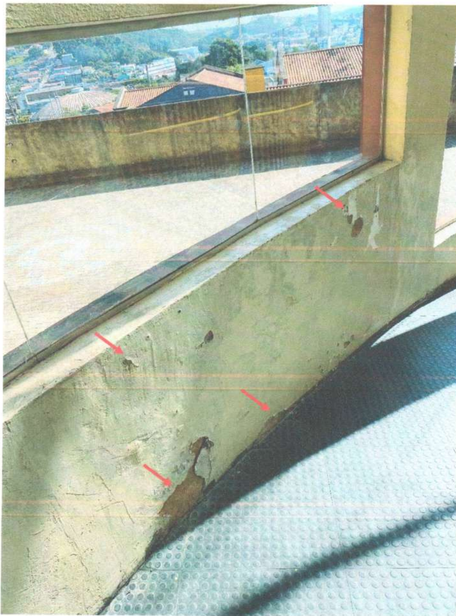
Foto 27 – Descascamento de pintura e reboco (Prioridade II, Classificação 3)
