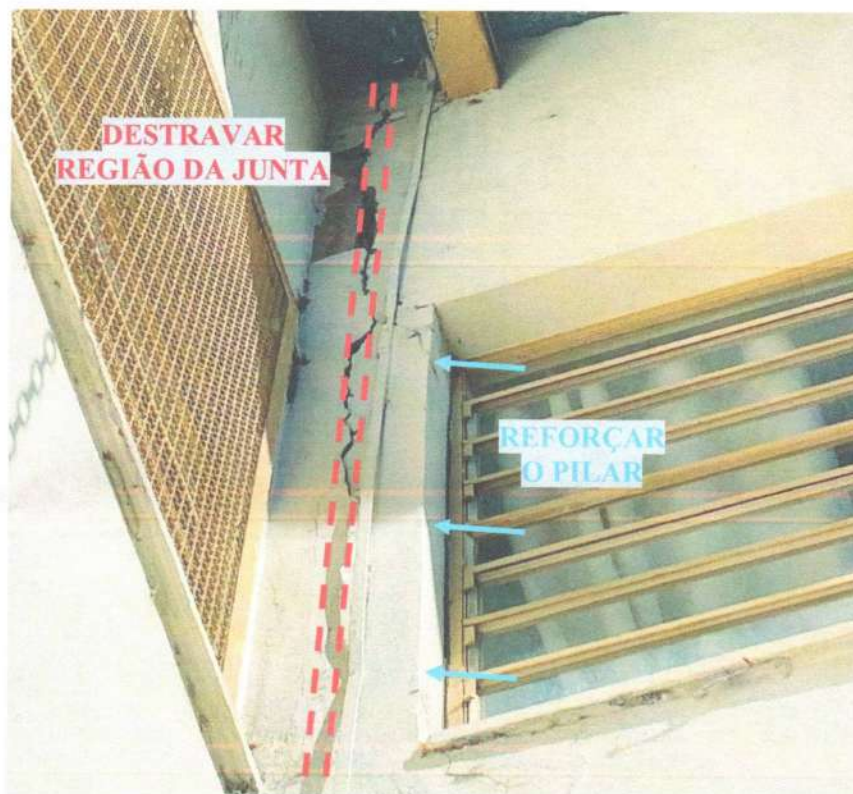
Pilar travado com fissurações
