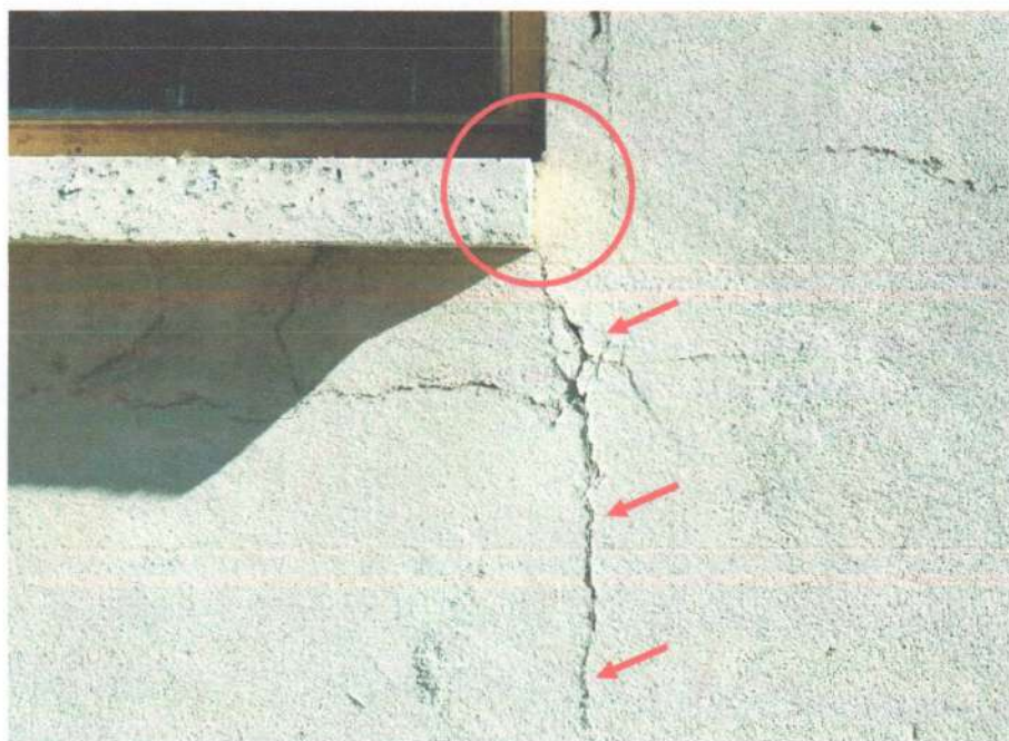
Foto 47 – Trincas e/ou fissuras e deficiência nas pingadeiras (Prioridade II, Classificação 3)
