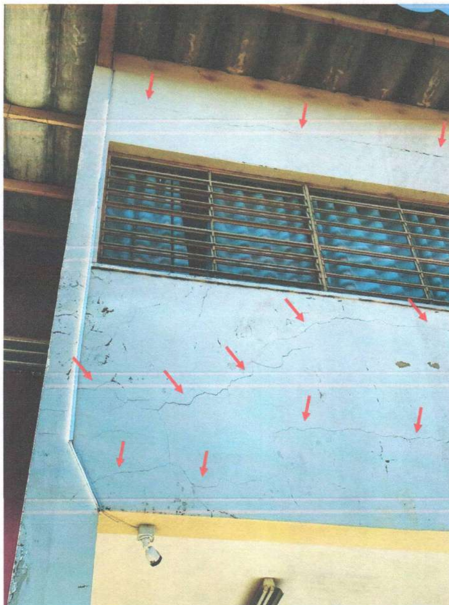
Foto 53 – Trincas e/ou fissuras (Prioridade I, Classificação 5)
