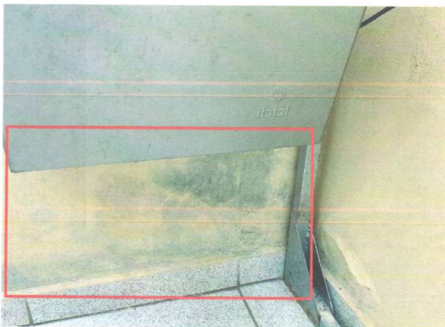
Foto 12 – Umidade por capilaridade ascendente (Prioridade II, Classificação 3)
