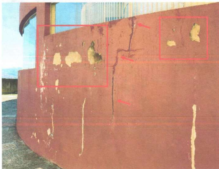
Foto 29 – Descascamento de pintura (Prioridade II, Classificação 3)
