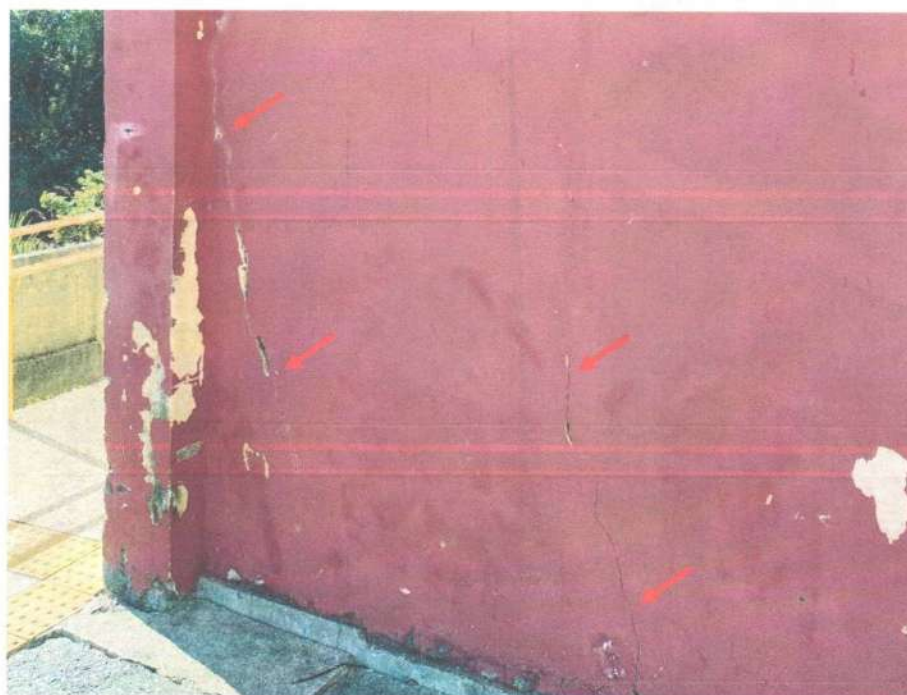
Foto 50 – Trincas e/ou fissuras (Prioridade I, Classificação 5)
