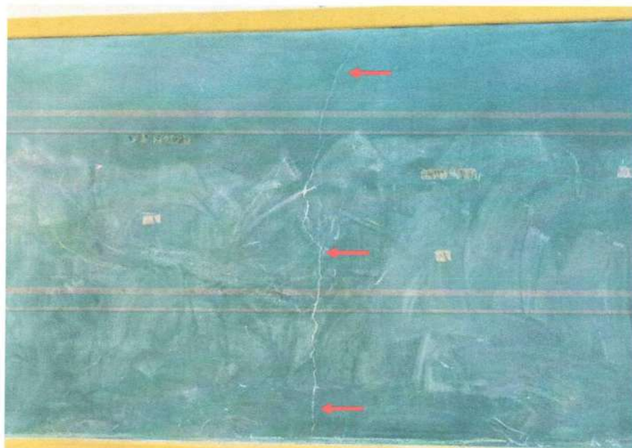
Foto 11 – Trincas e/ou fissuras (Prioridade I, Classificação 5)
