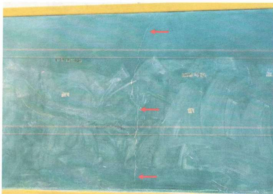
Foto 11 – Trincas e/ou fissuras (Prioridade I, Classificação 5)
