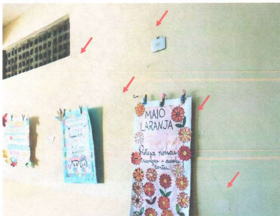
Foto 7 – Trincas e/ou fissuras (Prioridade I, Classificação 5)
