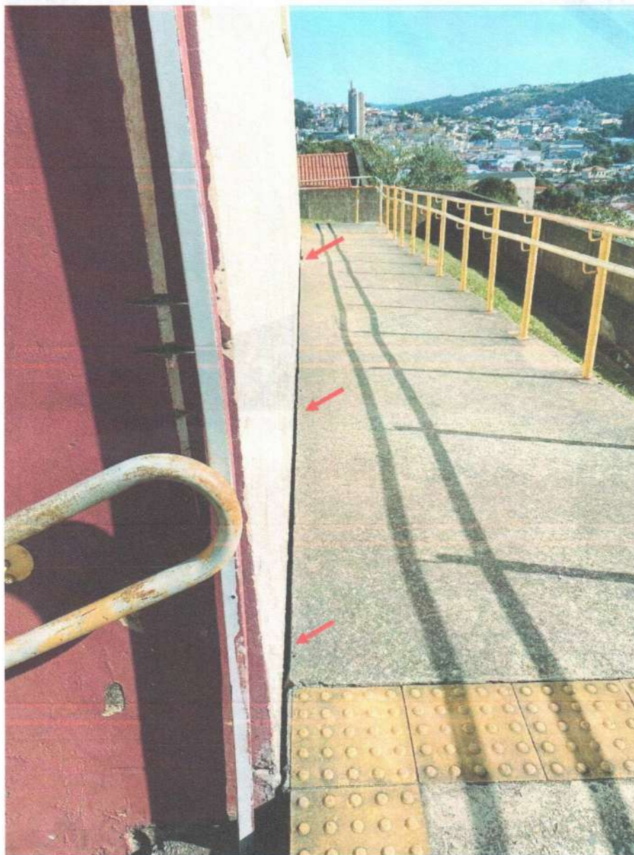
Foto 51 – Recalque de piso (Prioridade I, Classificação 5)
