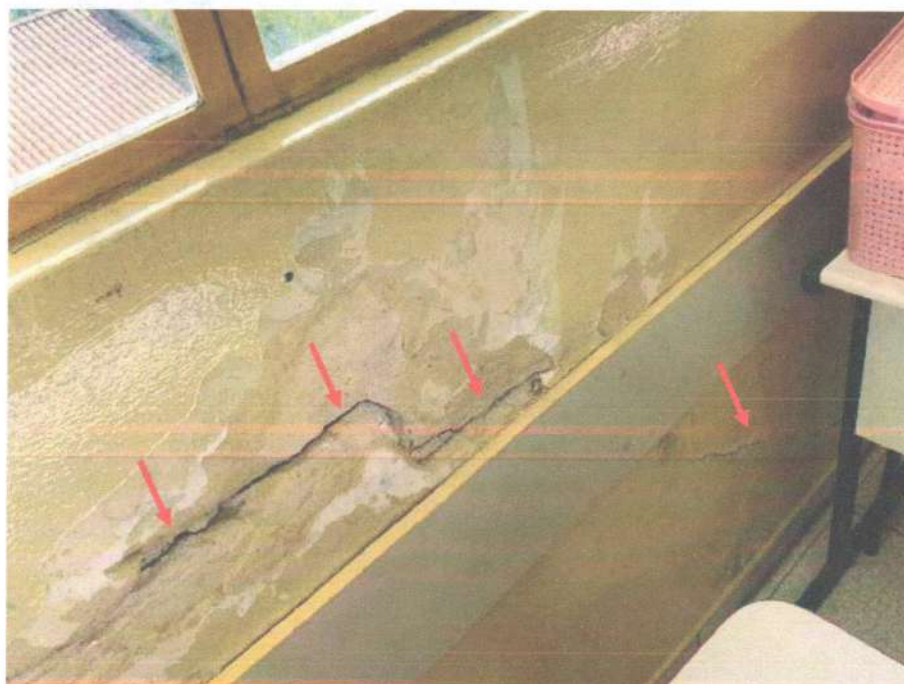
Foto 32 – Trincas e/ou fissuras (Prioridade I, Classificação 5)
