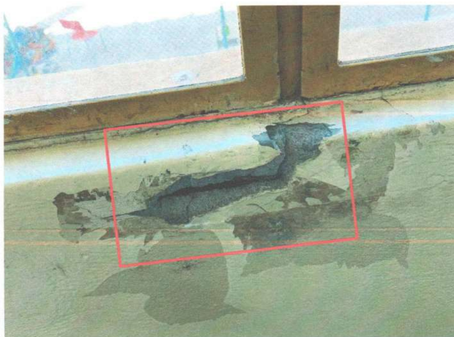
Foto 35 – Trincas e/ou fissuras (Prioridade II, Classificação 4)
