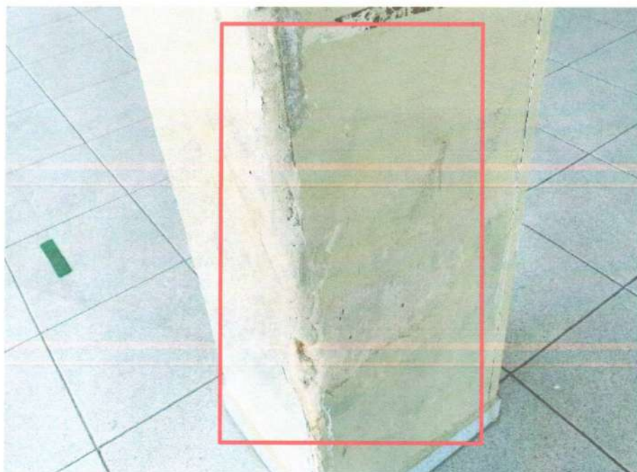
Foto 40 – Desagregação do reboco (Prioridade II, Classificação 3)
