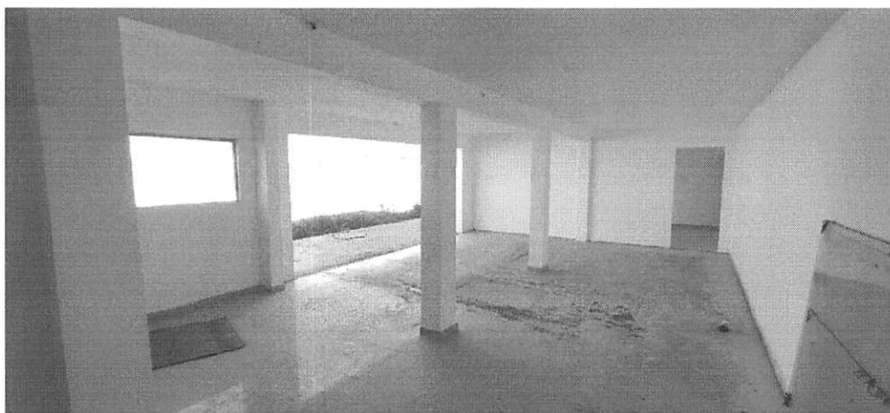
Imagem 06: Vista Parcial Pavimento Térreo
