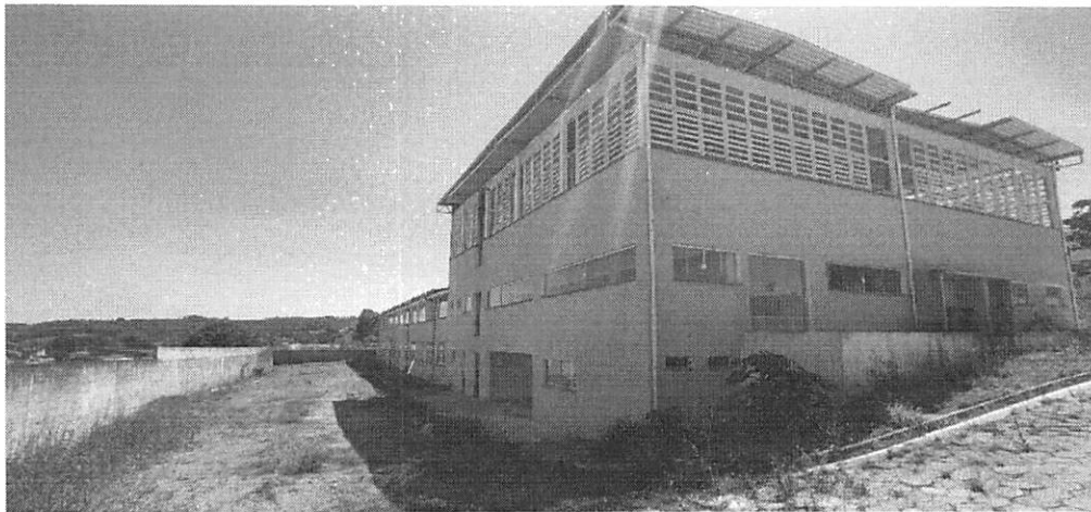
Imagem 07: Vista Panorâmica Externa
