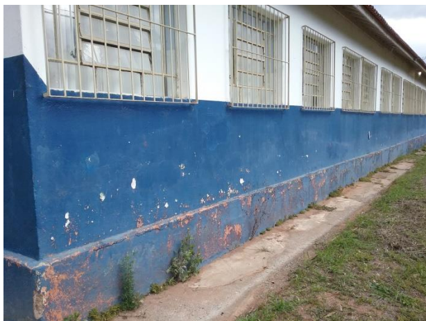
Foto 2 – Pintura das paredes da escola com sinais de deterioração.
