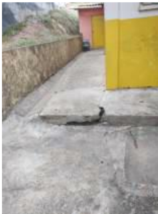
Foto 8 – Piso lateral danificado.
