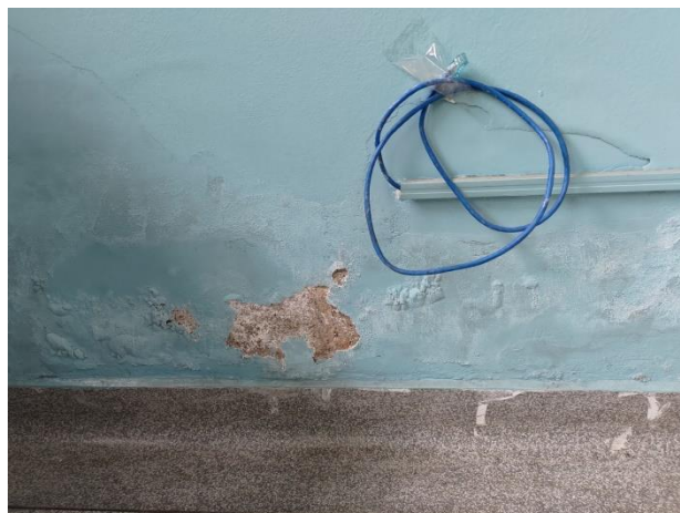
Foto 8 – Parede com infiltração.
