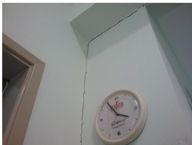
Foto 6 – Parede com trinca.
