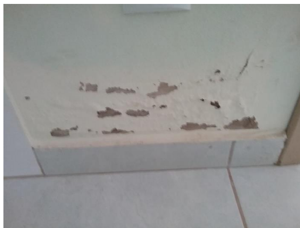
Foto 4 – Parede descascada em unidade de saúde.
