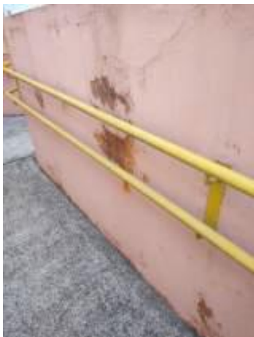
Foto 3 – Presença de umidade/mofo.
