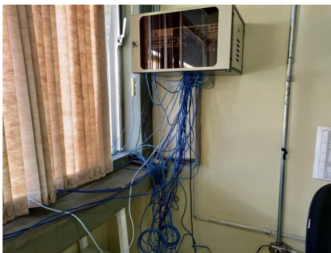
Precariedade na instalação de cabos de rede e internet em sala do Paço Municipal.
