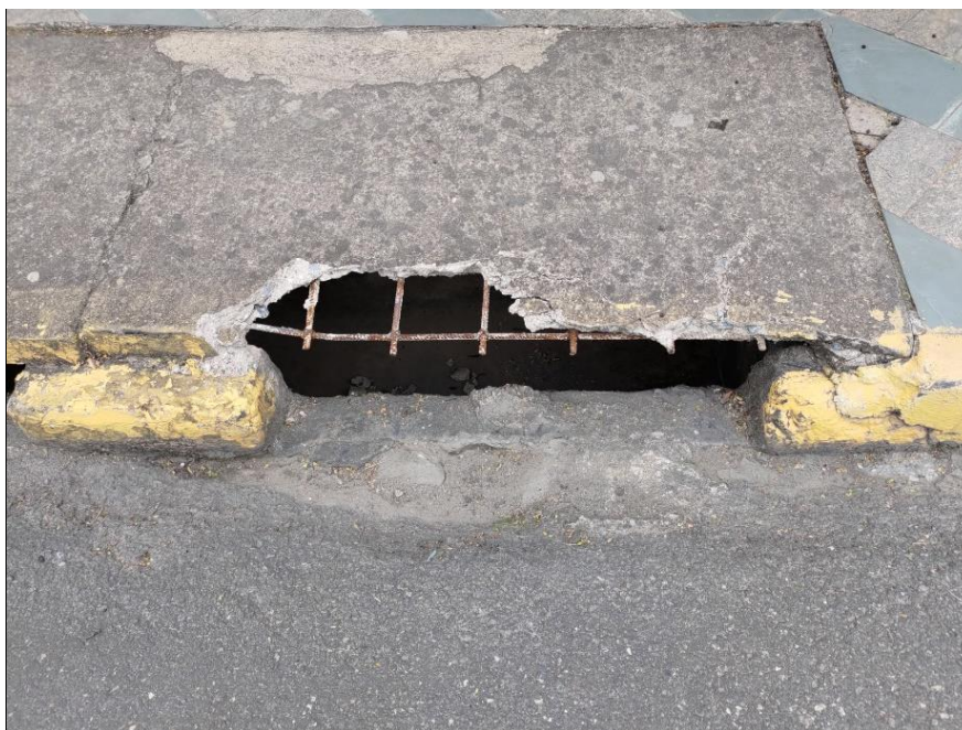
Tampa de bueiro quebrada, oferecendo riscos a pedestres.
