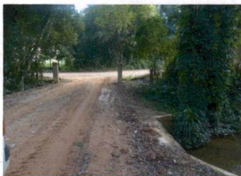
Vista do acesso da propriedade
