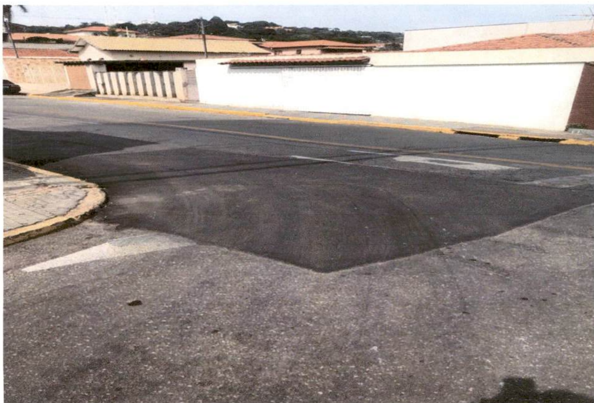
Esquina da Avenida Coração de Jesus com a Rua Antônio de Souza Lopes.
