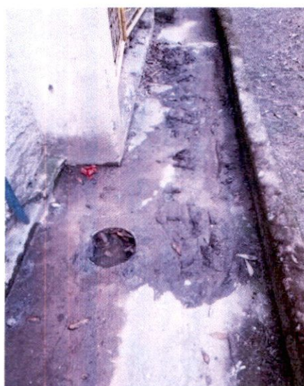
Escoadouro de água sem ralo e obstruído
