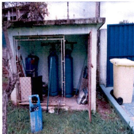
Abrigo de cilindros de gás aberto e com materiais diversos em seu interior
