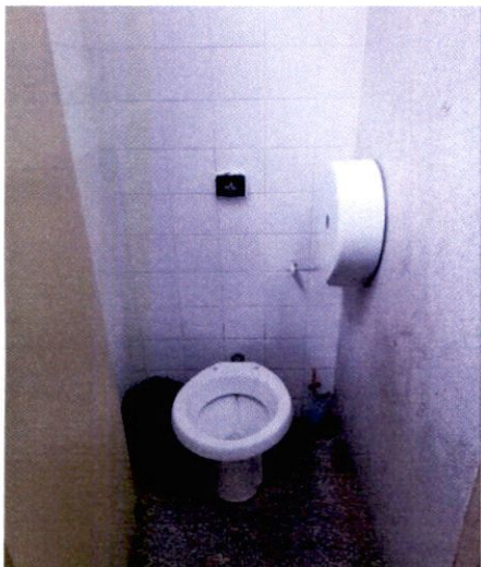
Ausência de: assento sanitário, de fechadura e de proteção da válvula de descarga
