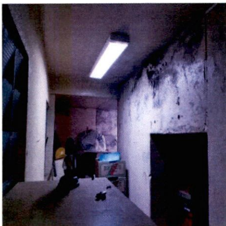
Presença de mofo e infiltração
